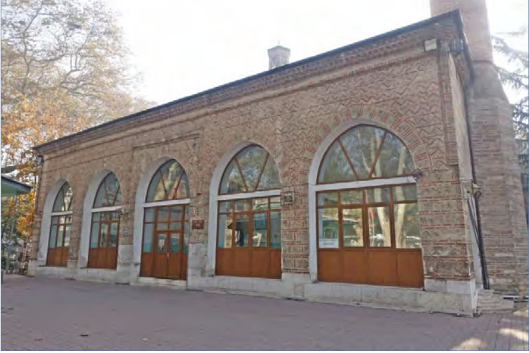
1: İŖhak PaŖa Camii Son Cemaat Yeri Cephesi
